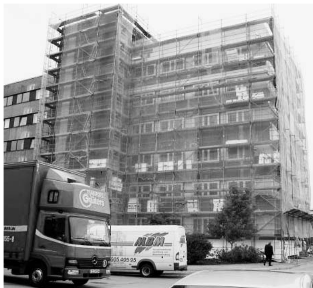
Baustelle LISUM: Uhlandstraße, Alte Jakobstraße, Storkower Straße, jetzt Alt-Friedrichsfelde – demnächst Ludwigsfelde/Struveshof?
